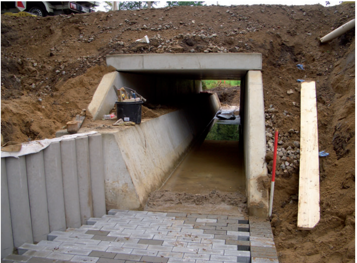
Los cuatro elementos prefabricados de hormigón, con una longitud total de 17,4 metros y un ancho de 2,4 metros, forman el cruce de carreteras para nutrias y el tramo del arroyo de Moorsaalweide
