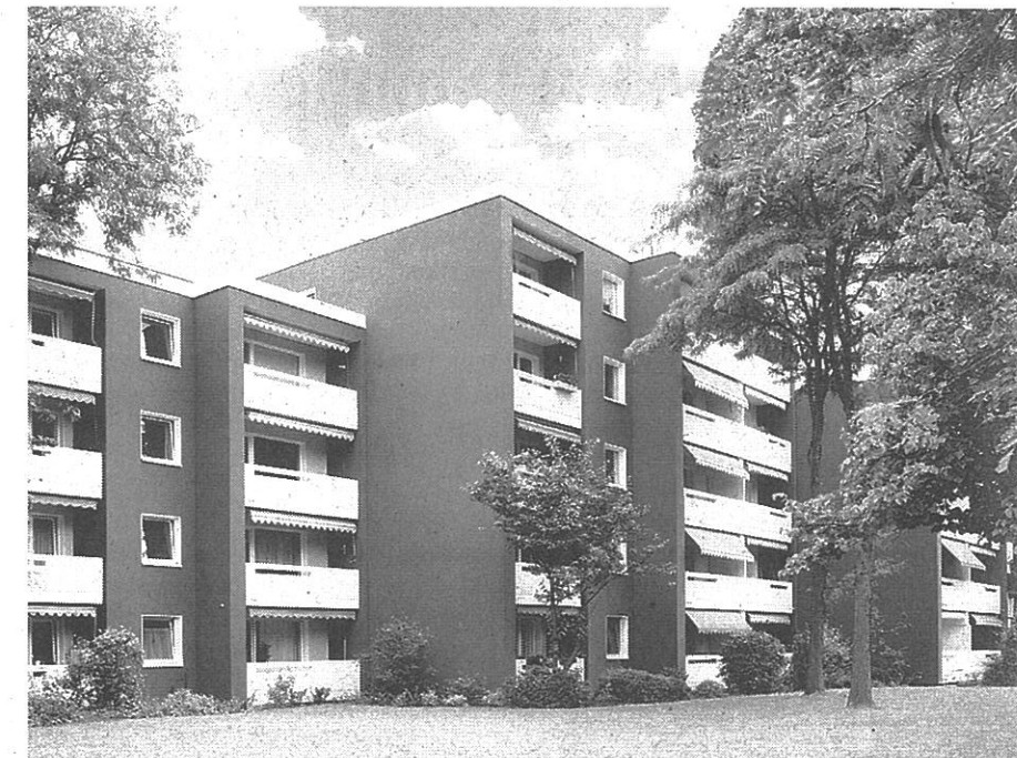
Der aus dem Jahr 1976 stammende Wohnblock wurde hochwertig saniert. Die ursprüngliche kräftig rote Farbe sollte nach einer Umfrage der Mieter beibehalten werden. Fotos: Caparol
