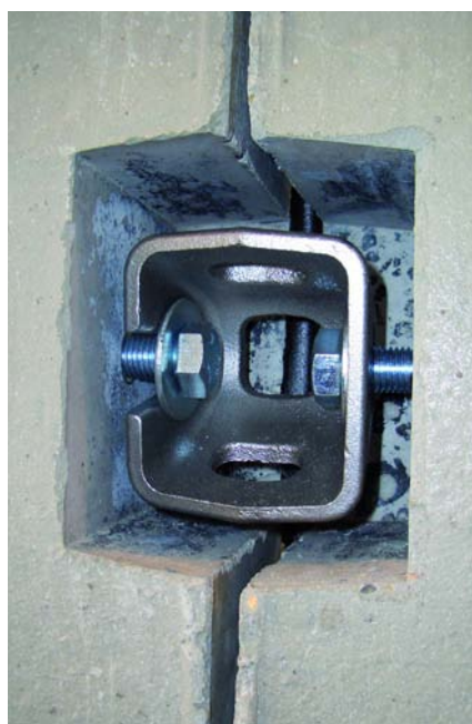
Железобетонные элементы, соединенные при помощи крепежной муфты – в области шва просматривается герметизирующая лента RubberNEK.
